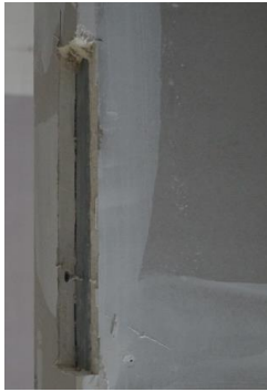
Ausnehmen der GK-Platte für die Wandanker
