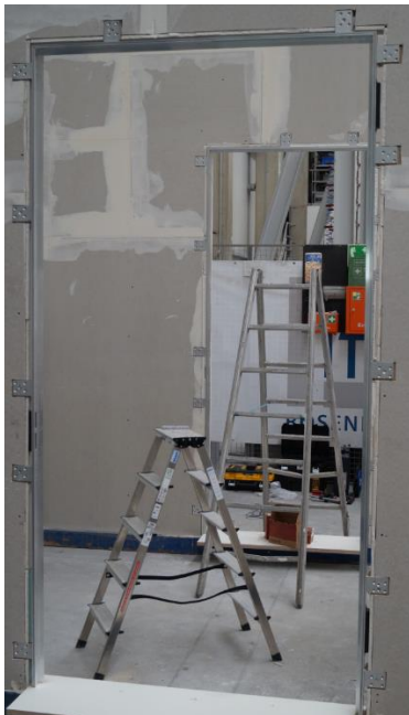
Verschraubung der Wandanker In der Wandfläche
