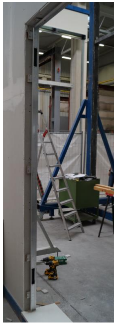
Verschraubung der Wandanker In der Leibung
