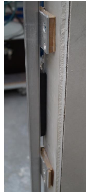
Detailaufnahme Hinterklotzung in der Leibung
