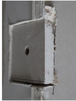
Hinterfütern der Wandanker
