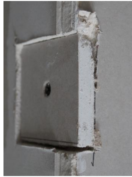
Fourrage des ancrés muraux
