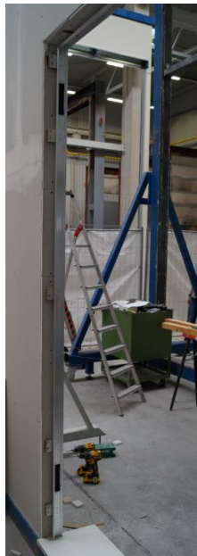
Vissage des ancrés dans l'embrasure
