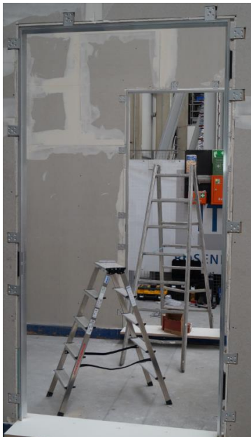
Vissage des ancrés sur la paroi
