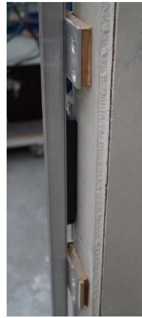
Vue en détail du calage dans l'embrasure
